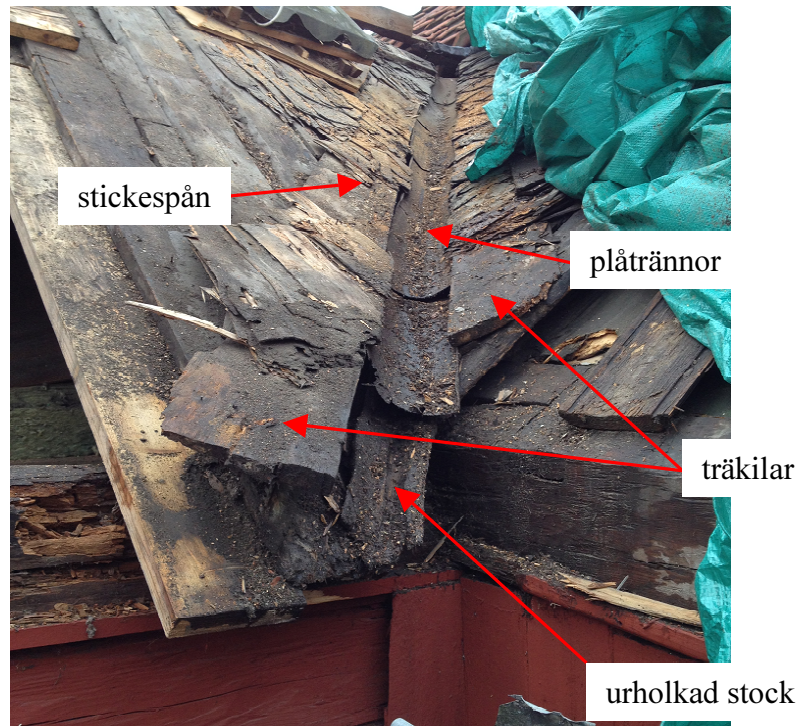
Rännal med urholkad stock, träkilar och stickespån.
