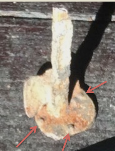
De korta spikarna är smidd plåtspik för bly och koppar med stift under skallen för att hålla fast plåten bättre.
